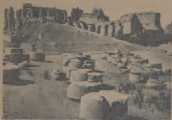
1. PLAN INCLINÉ POUR LA DÉMOLITION DES COLONNES
